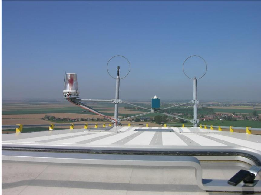
*Photo d'un balisage installé en nacelle*
